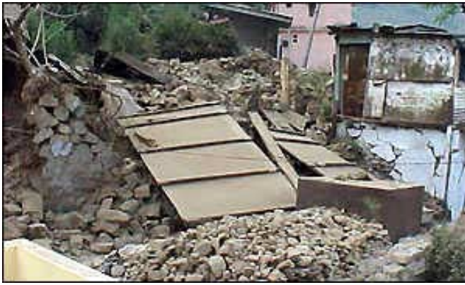
Miles de casas fueron completamente destruidas en el terremoto de Uttar Pradesh en India. [BBC News]
