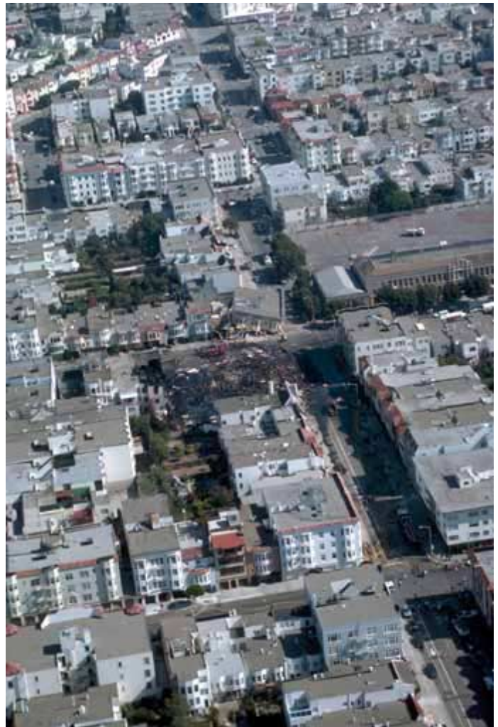
Vista aérea de edificios colapsados y una sección incendiada en las calles Beach y Divisadero , del Distrito de Marina, California. [C.E. Meyer, U.S. Geological Survey]
