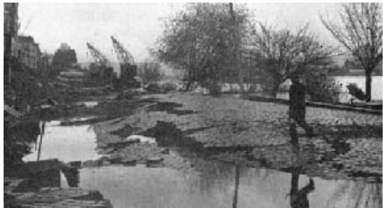
La costanera de Valdivia, arriba, fue completamente destruida por las sacudidas del terremoto de 1960. Como se aprecia, la calle quedó imposibilitada de ser utilizada como vía de escape en automóvil.
